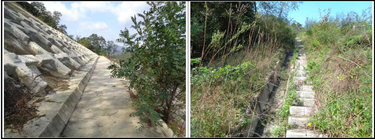
【그림 22.3.3】 배수시설 전경
