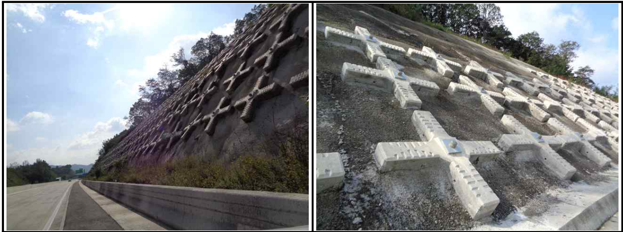
【그림 22.3.4】 보호/보강시설 전경
